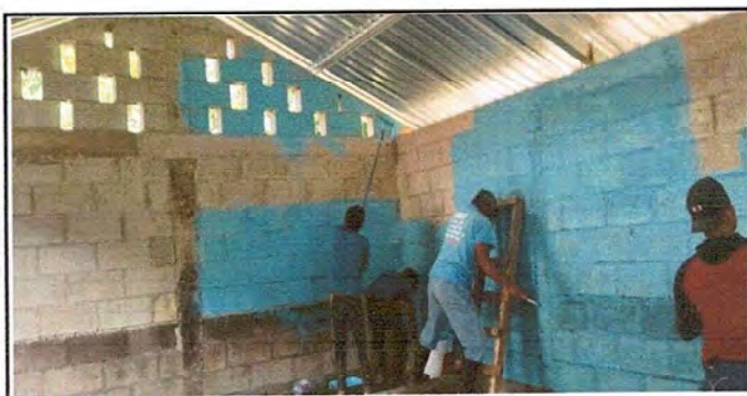
Fotografía colocando la pintura de la cocina del centro educativo
