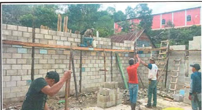
Fotografías de la ampliación del aula de primer grado primaria.
