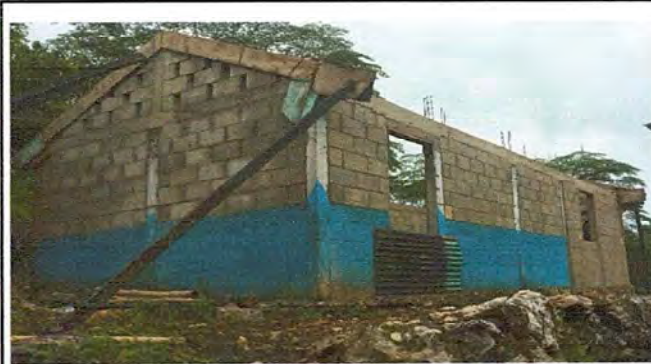
Fotografía de la cocina culminando de la ampliación.
