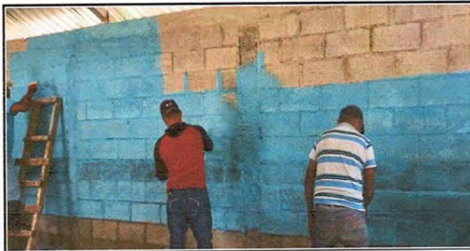
Fotografía donde se observa pintando en el interior del aula de primero primaria.
