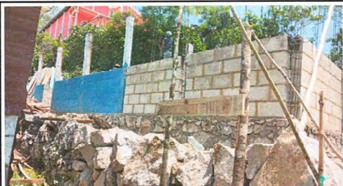
Fotografía de la cocina del centro educativo durante los trabajos de remozamiento
