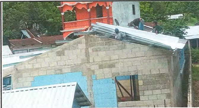
Fotografías del cambio de techo del aula de primero primaria.
